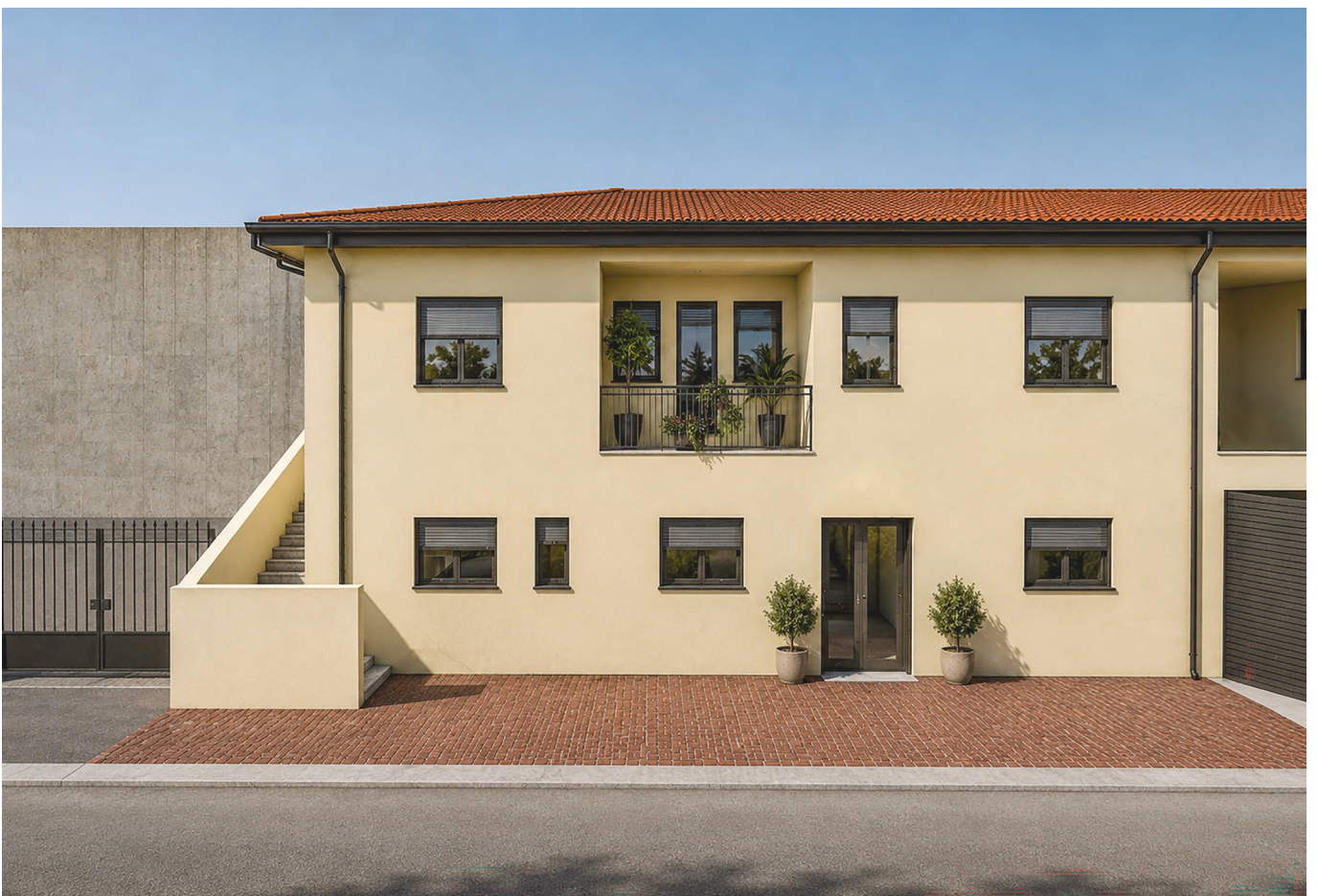
Bocco primo (esterno) - sede fondazione a piano terra, foresteria a piano primo
